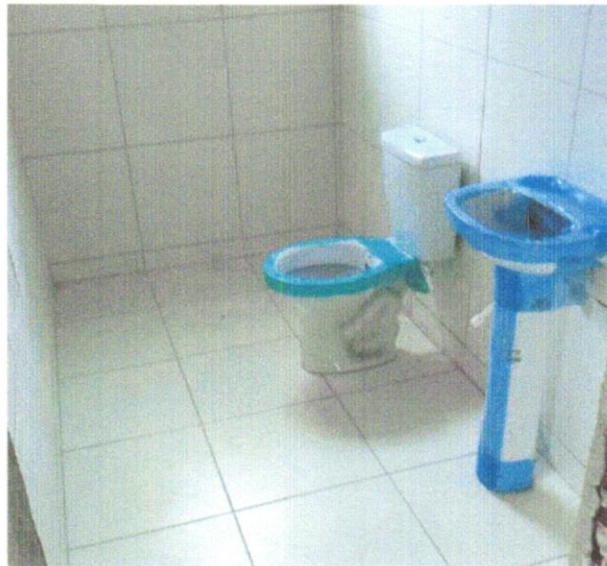
FOTO 03 -VASO SANITARIO SIFONADO CONVENCIONAL COM LOUÇA BRANCA – FORNECIMENTO E INTALAÇÃO AF 01/2020, CAIXA DE DESCARGA DE SOBREPOR COMPLETA AKROS OU SIMILAR
