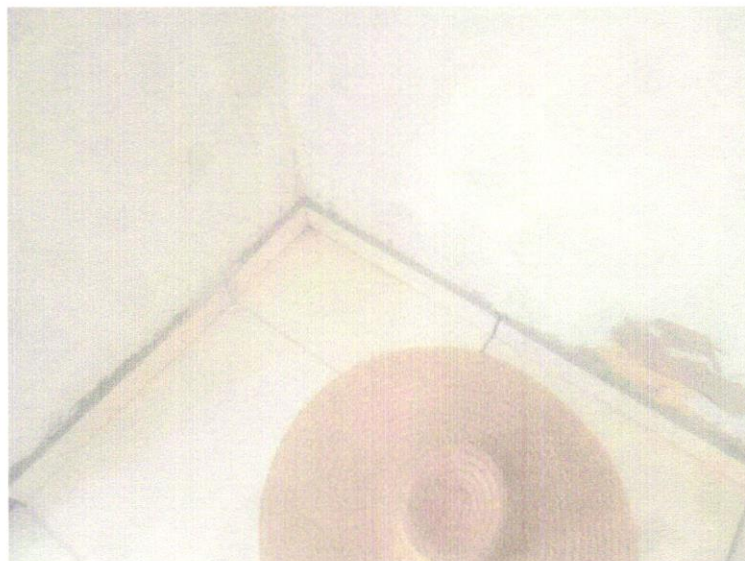
FOTO 06 – RODAPÉ CERÂMICO DE 7CM DE ALTURA COM PLACAS TIPO ESMALTADA EXTRA DE DIMENSÕES 45X45CM AF 06/2014
