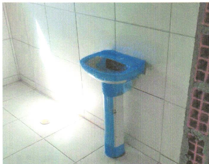
FOTO 02 – LAVATÓRIO DE LOUÇA BRANCA COM COLUNA, 45 X 55CM OU EQUIVALENTE, PADRÃO MÉDIO – FORNECIMENTO E INSTALAÇÃO
