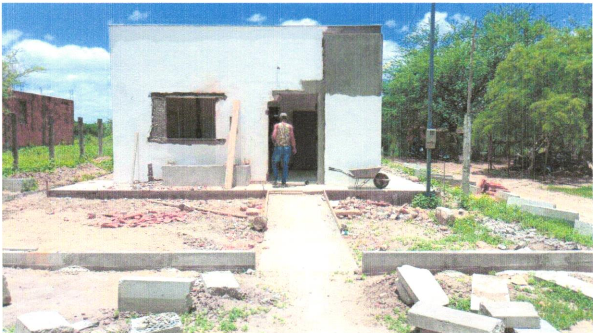
FOTO 12 - APLICAÇÃO E LIXAMENTO DE MASSA LÁTEX EM PAREDES, UMA DEMÃO. AF_06/2014
