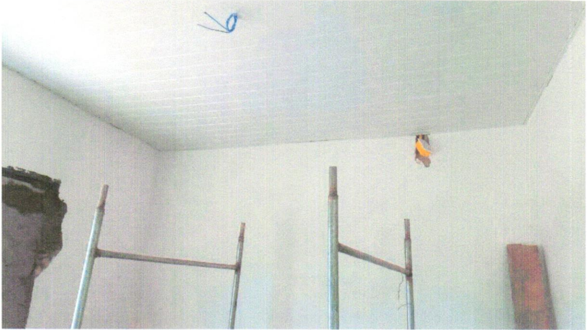
FOTO 13 -Forro de pvc, em régua de 10 ou 20 cm, aplicado, inclusive estrutura para fixação (perfis em PVC) marca Araforros ou similar, instalado - Rev 06_10/2021
